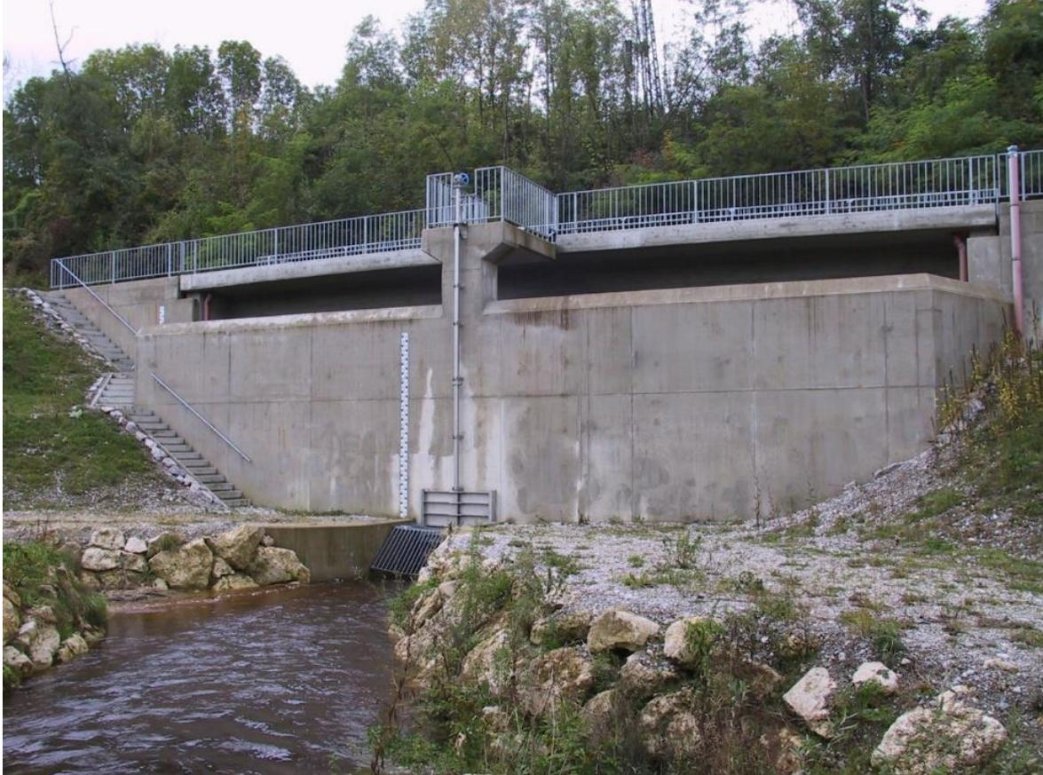
Abbildung 3: Stau-mauer mit Notentlastung am Hochwasserrückhaltebecken Wilzhofen
